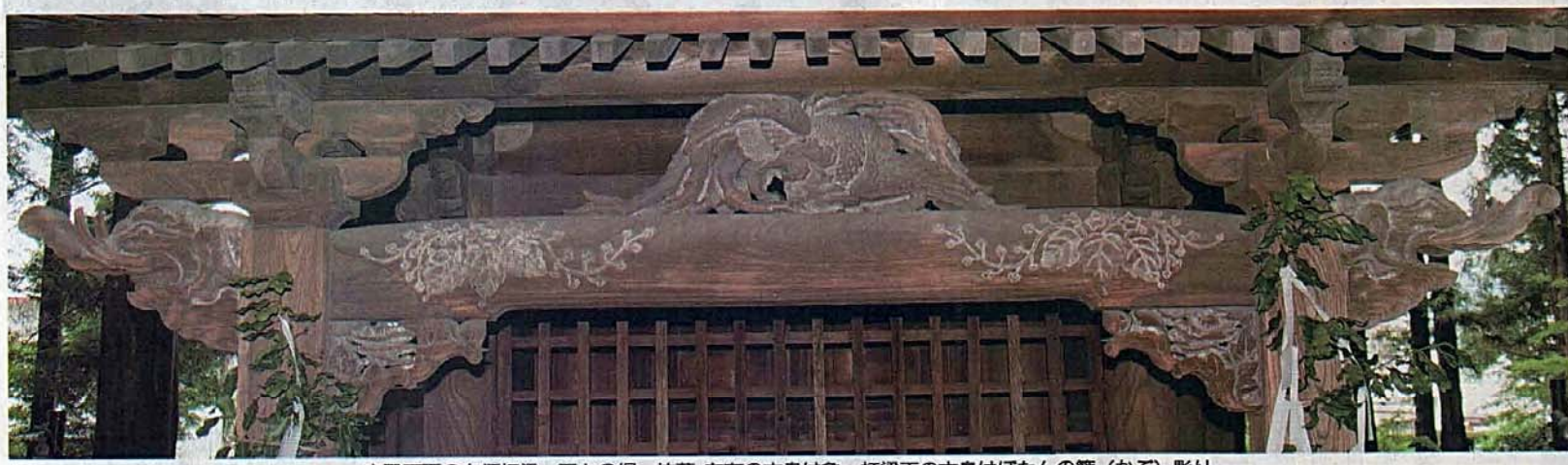
本殿正面の向拝虹梁。五七の桐、枝葉、左右の木鼻は象、虹梁下の木鼻はぼたんの籠(かご)彫り
