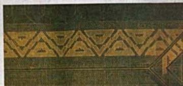
屋根の図面に描かれた不思議な紋様(シェvron=chevron、山形・逆V字形=上の写真)。近くで見ると名残があるが、経年劣化で鮮明ではない。一体何のためにこの様な紋様を描いたものか? スレートをひっかいて目を変えたものか? 竣工してから数年後に発行された絵はがき(右の写真)には紋様がかっきり写っている
