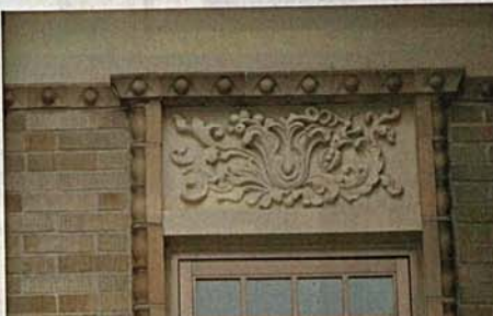
高遠丸千窯のスクラッチ (scratch=ひっかく) タイル。旧岡谷市役所などあちこちに残っている。この時代のタイルは質の割に付着がよく、剥落しない。貧調合(セメントが少ない)のがよいという意見がある。現代のタイルは品質はよいが、付着が悪く剥離、剥落が多発している。化粧のボーダー(border=縁)タイルのデザインは高遠電燈の建物に使われたタイルに酷似していることから、使われている役物のタイルもすべて丸千組で造られたと考えられる。丸千組は製糸の製陶鍋や半月鍋も製造した
