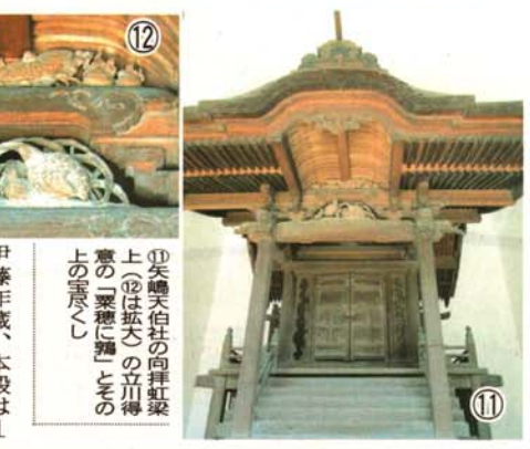
⑪伊藤作蔵、本殿は1754年(宝暦4)の建築。金囊、小槌、宝珠、丁子が見える。写真⑫は茅野市横内の矢嶋天伯社。2代立川和四郎富昌が1850(嘉永3)年に造った。向拝の虹梁の上は立川得意の「粟穂に舞」でその上の桁(けた)の上に宝尽くしが見える。覆屋で厳重に保護されていて下からのぞき込まないと見えないが、品のよい小さな小槌、笠、宝珠、巾着が見える。
