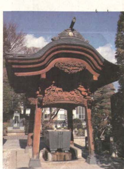
【水屋】切妻の妻入りの両側を唐破風とし左右にも唐破風をつけ、4面に唐破風の見える重厚な建築である。水盤は1932(昭和7)年の山岸卓三作
