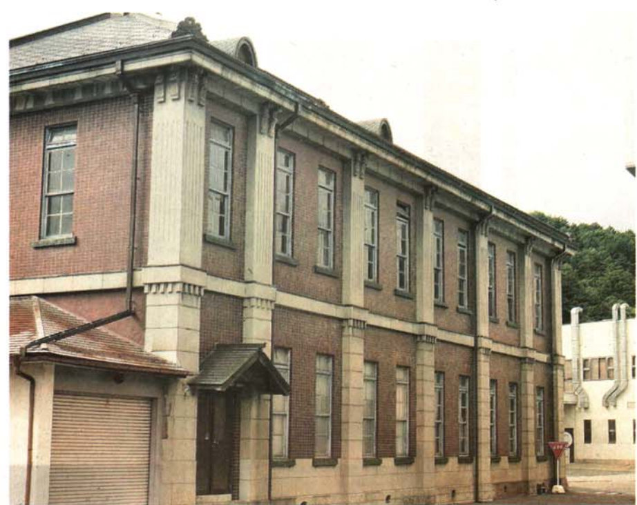
瀟洒な外観。柱は飾り位置は東西で異なる。東西の屋根には各2カ所にドーマー窓が付いている
